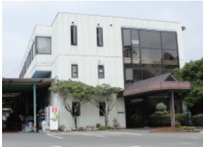
小山工場 Oyama Plant
